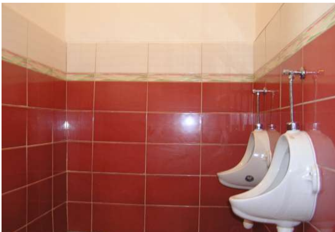
Rekonštrukcia sociálnych zariadení v budove OV
