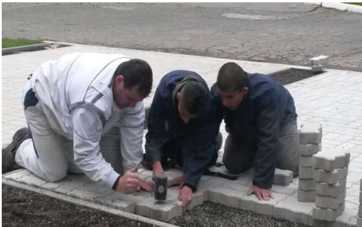
Výstavba parkoviska pred telocvičňou
