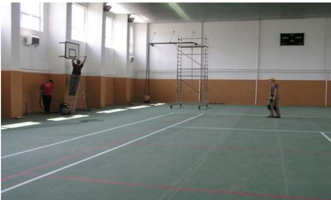
Práce na dokončení telocvične
