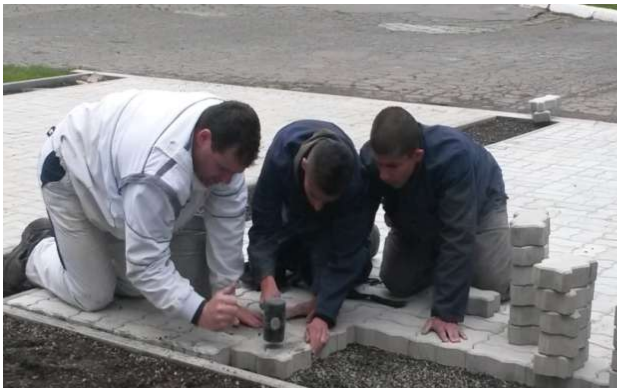
Výstavba parkoviska pred telocvičňou
