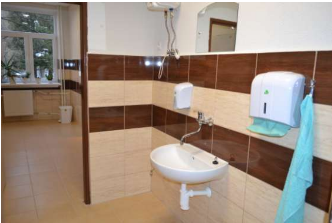
Rekonštrukcia sociálnych zariadení v budove školy
