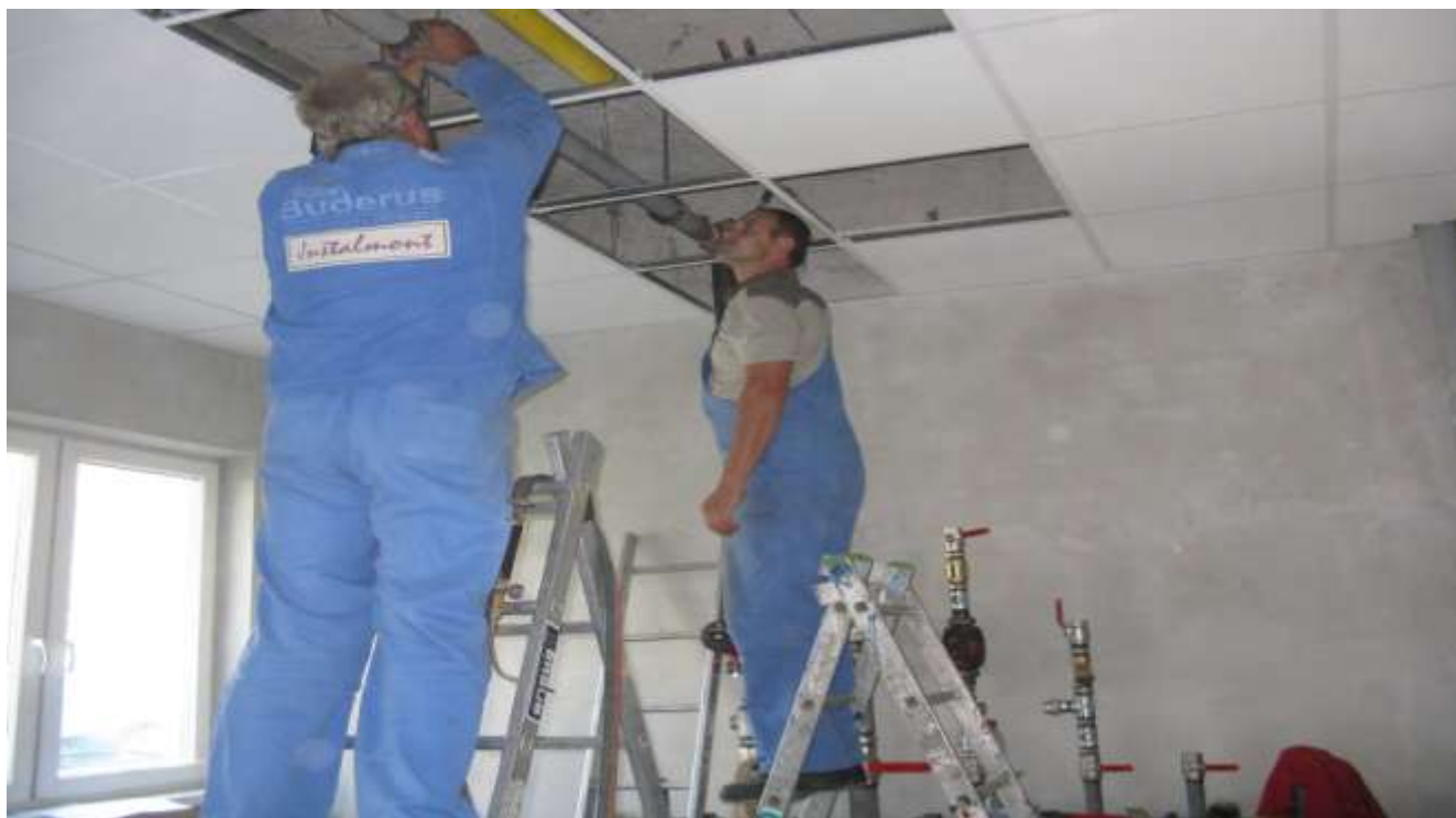
Práce na dokončení telocvične – vykurovanie
